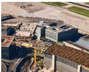
**Aéroport international Zurich, Kloten (Suisse) :** Membranes de toiture Sika® Sarnafil®, revêtements de sols Sikafloor®, enduits protecteurs SikaCor® pour l'acier structural, différents types d'adjuvants pour béton Sika incluant la technologie Sika® ViscoCrete®.
