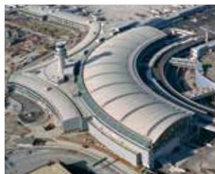
**Aéroport international Lester B. Pearson - T1, Toronto (Canada) :** Membrane de toiture Sika® Sarnafil® fixée mécaniquement et revêtements de sols intérieurs Sikafloor® dans l'aérogare.
