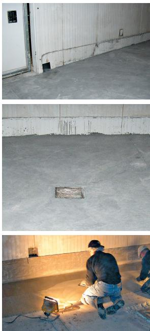
Le revêtement de sol de la salle de congélation d'une usine de fabrication d'aliments s'est rapidement détérioré et a dû être remplacé seulement un an après son installation. Le revêtement de sol mis en place initialement ne pouvait supporter les changements brusques de température reliés au lavage à l'eau chaude. L'infiltration d'eau sous le revêtement a fait écailler la surface en plus de créer des fissures autour des drains.
