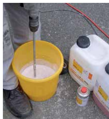
Malaxage d'une résine d'injection acrylique
