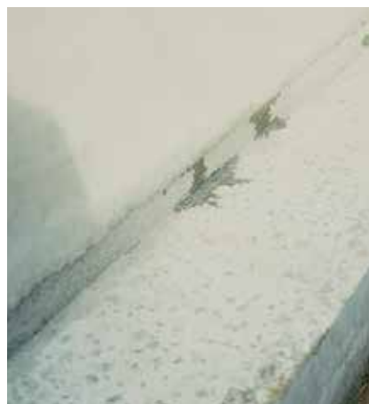
Processus d'injection unique sur site
