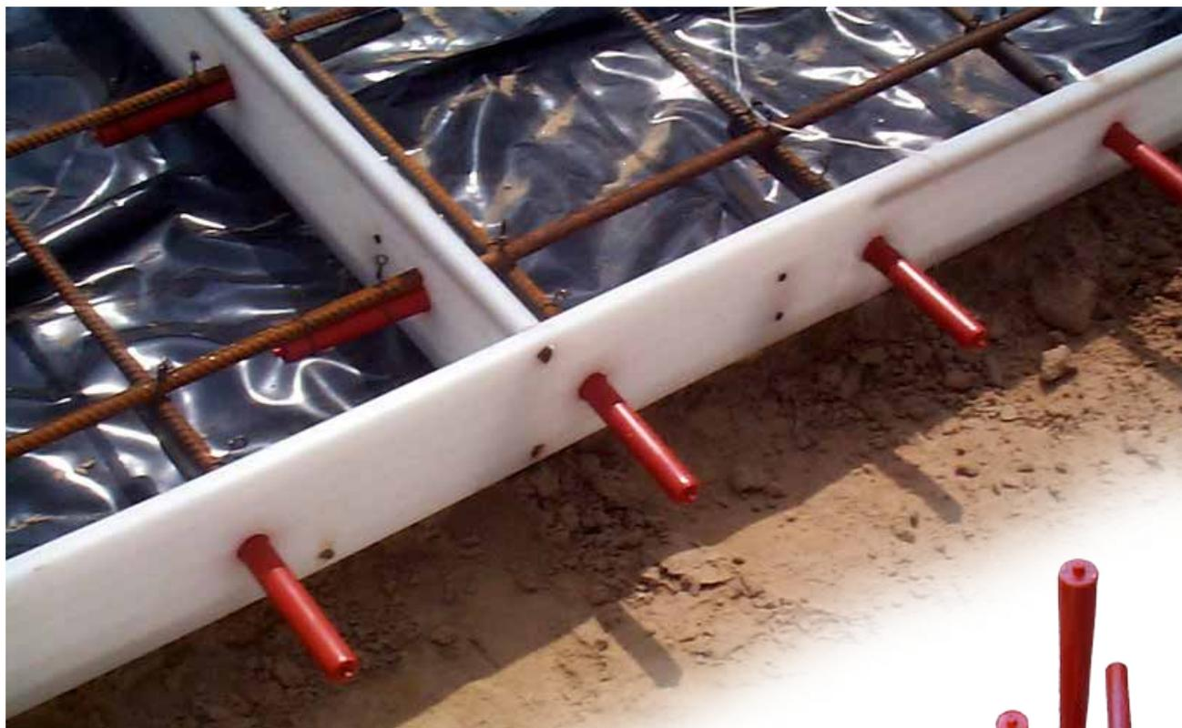
Speed Load™ est un fourreau à goujon fabriqué d'une seule pièce et utilisé dans les joints de dilatation. Speed Load™ est inséré à travers les plaques d'expansion pré-perçées ; il est doté d'un système autobloquant permettant au goujon de rester en position et de garder l'alignement pour assurer un transfert de charge positif. Speed Load™ est illustré ci-dessus, installé avec la plaque d'expansion en polypropylène Sika® Greenstreak®.
