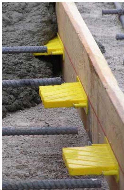
La SPEED PLATE® de Sika réduit le nombre de goujons nécessaires par rapport aux systèmes conventionnel et permet à l'installateur d'augmenter la distance entre les axes des goujons plats, ce qui réduit encore plus des frais de main d'œuvre et de matériaux. Le tableau des espacements se base sur des recommandations prudentes en termes d'espacement et conformes à la norme ACI 360R-10.
