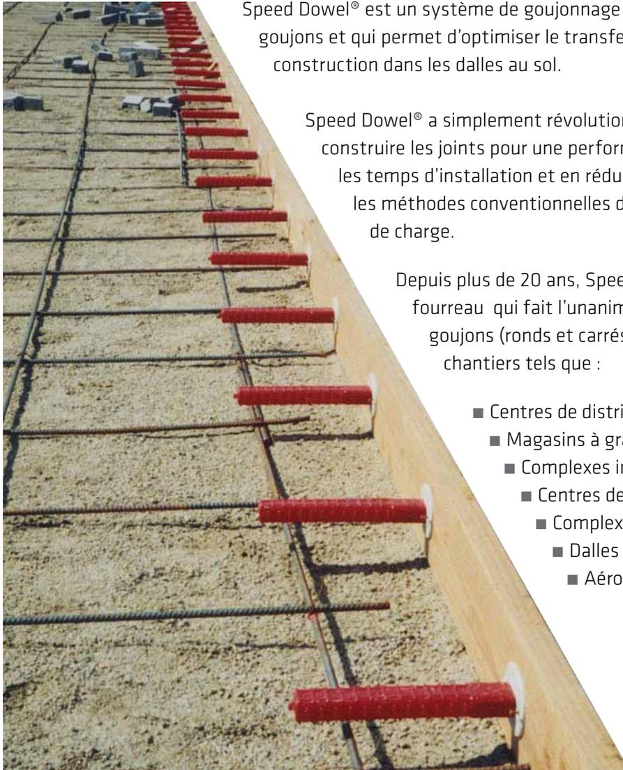
Speed Dowel® est un système de goujonnage garantissant l'alignement des goujons et qui permet d'optimiser le transfert de charge au niveau des joints de construction dans les dalles au sol.
