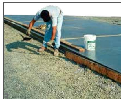
3 Découpez et insérez les goujons non-graissés dans les fourreaux Speed Dowel®
