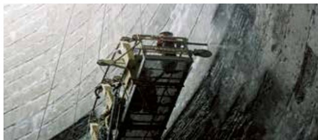
Remplacement et restauration du béton endommagé avec des bétons et des mortiers spéciaux haute performance : Sika MonoTop®, SikaCrete® SCC, Sika® ViscoCrete®, SikaRapid®, SikaGard®EpoCem®, Sikadur®
