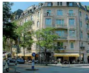
Hôtel Ambassador, Zürich (Suisse) : Systèmes d'étanchéité, solutions de réfection et de protection du béton Sika®.
