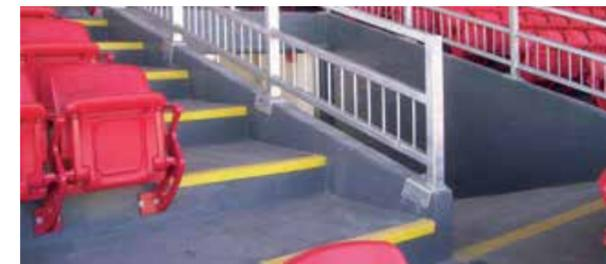
Systèmes de revêtements de sol Sikafloor® pour la protection des zones exposées à la circulation des spectateurs et des gradins.
