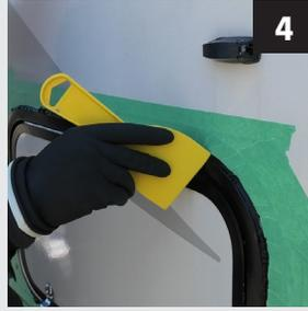
4 Effectuez le lissage et la finition du mastic à l'aide d'un outil de finition approprié (maximum 30 minutes après l'application).
