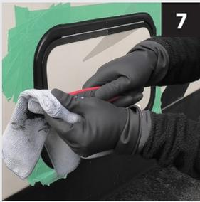
7 Nettoyez immédiatement le mastic non-durci des outils et des surfaces avec le **Sika® Remover-208**. Le produit durci ne pourra être enlevé que mécaniquement.
