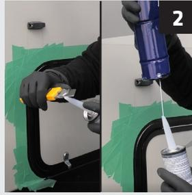
2 Taillez la buse du **Sikaflex®-221** selon la largeur de joint désirée et percez l'opercule d'aluminium obturant l'embout de la cartouche.
