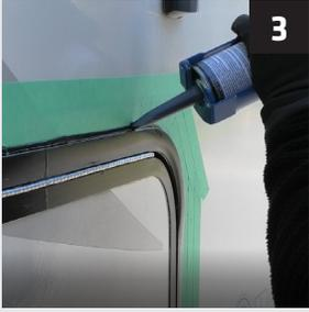
3 À l'aide d'un pistolet applicateur<sup>2</sup>, extrudez le mastic **Sikaflex®-221** sur la surface d'application
