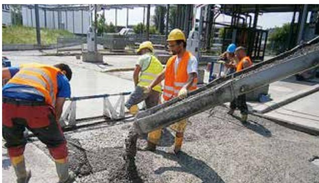
Les macro-fibres synthétiques SikaFiber® Force ont été utilisées de concert avec la méthode allemande de recouvrement mince en béton pour la réparation des dalles dans le port pétrolier de Stuttgart. Les fibres ont été utilisées pour améliorer le comportement en fatigue de la nouvelle couche de béton.
