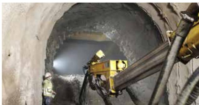
Les macro-fibres synthétiques SikaFiber® Force ont été ajoutées au béton projeté pour augmenter l'endurance du revêtement en béton. Cette sorte de béton projeté renforcé de fibres produit une stabilisation des parois et des voutes plus efficace et plus économique.
