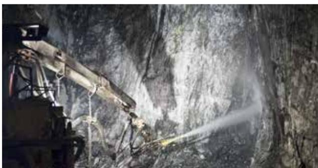
Dans ce projet d'exploitation minière, les macro-fibres synthétiques SikaFiber® Force ont été utilisées pour le béton projeté, notamment pour la stabilisation des parois et des voutes. Leur sélection et utilisation ont garanti un déroulement des travaux efficace, économique et sécuritaire au fur et à mesure de l'avancement des machines.
