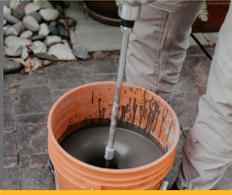
Malaxer le produit à basse vitesse dans un récipient approprié avec un mélangeur à mortier ou une perceuse équipée d'une pale de malaxage adaptée pour obtenir une grande fluidité avec un dosage minimal d'eau. Se référer au rapport de malaxage indiqué dans la section des données techniques ci-dessous.
