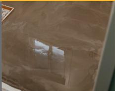
Le produit s'autonivelle pour produire une surface plane et de niveau, prête à recevoir le revêtement de sol.
