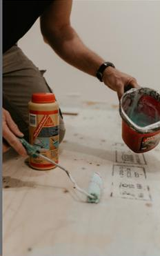
L'utilisation d'un apprêt tel que Sika® Level-01 Primer<sup>CA</sup> est recommandée avant l'application de l'autonivelant sur les planchers en béton ou cimentaires. Pour le traitement de substrats en bois, utiliser l'apprêt Sika® Level-03 Primer<sup>CA</sup>. Appliquer l'apprêt au pinceau ou au rouleau puis le laisser devenir translucide avant de couler la sous-finition.
