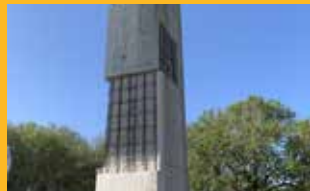
RÉPARATION DU BÉTON
