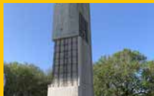
RÉPARATION DU BÉTON
