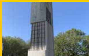
RÉPARATION DU BÉTON
