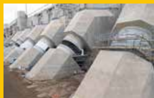
PRODUCTION DE BÉTON
