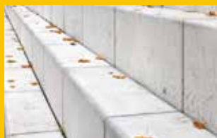
SCELLEMENT DE JOINTS
