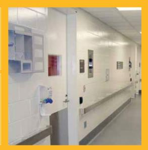
**Conseil Sika :** Pour conserver la couleur du Sikagard® Duroplast 100 dans le temps, terminer par une couche de Sikagard® Duroplast 150.
