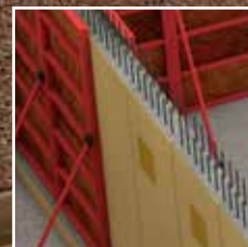
Murs, coffrage double face
