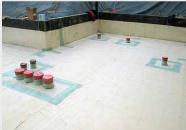
Finition de joint interne terminée
