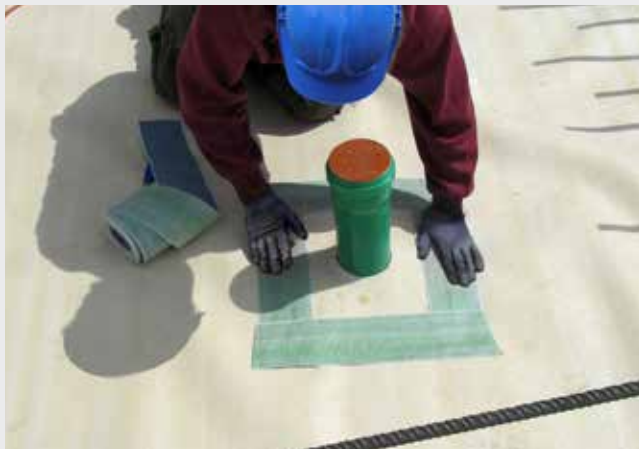
Finition de joint interne avec SikaProof® Tape-150
