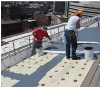
Étape 2 - ISOLATION/PANNEAU DE RECOUVREMENT (conforme au devis)
