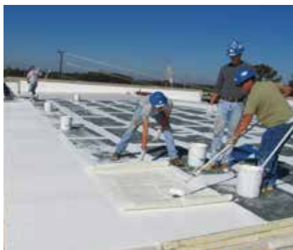
Étape 5 - APPLICATION DE LA MEMBRANE
