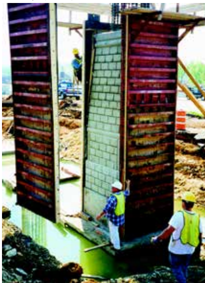
Coffré en place
