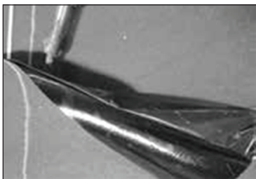
Hot-air weld Vapor Retarder SA 106 end laps
