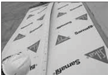
Vapour Retarder SA 31 laid in place
