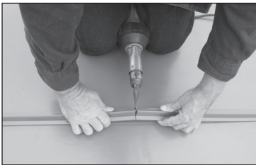
Preassembling Décor Profiles
