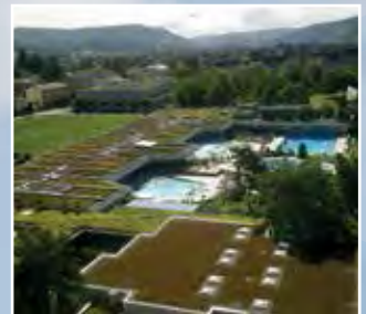
La première toiture verte Sarnafil a été installée en 1969. Elle est encore en place.
