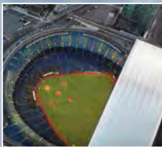
La toiture du Sky Dome de Toronto a été installée en 1989 et est encore en service.
