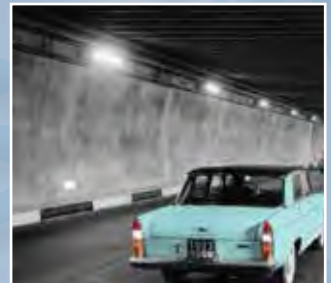
Étanchéité de tunnel en suisse (1966). Première application de Sarnafil dans ce contexte.
