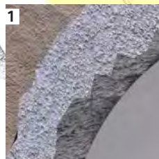
1 Premier revêtement en béton projeté
