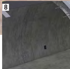
8 Revêtement secondaire en béton
