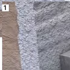
1 Revêtement principal en béton projeté
