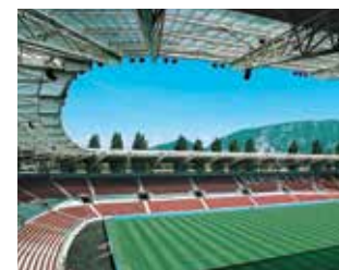
Stade de Genève, Genève (Suisse) : Solutions Sika appliquées : Adjuvants pour béton, revêtements de sols protecteurs, adhésifs pour parquets et enduits anticorrosion pour l'acier.
