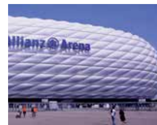
Allianz Arena, Munich (Allemagne) : Solutions Sika appliquées : Produits pour le traitement des joints et l'encollage de parquets
