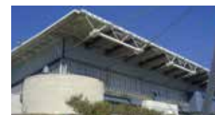
AIS Arena, Canberra (Australie) : Solutions Sika appliquées : Système de toiture (en service depuis 34 ans et fonctionne sans aucun problème).
