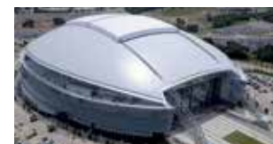
Cowboys Stadium, Dallas (É.-U.) : Solutions Sika appliquées : système de toiture, revêtements de sols et traitement des joints.
