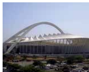
Stade Moses Mabhida (Afrique du Sud) : Solutions Sika appliquées : Mastics pour le traitement des joints, système de protection du béton et coulis
