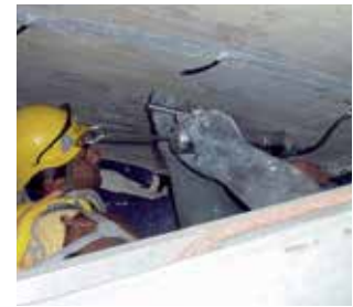
Traitement des fissures et des joints : Sika® Injection, Sikaflex®, Sikadur® Combiflex System
