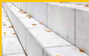
SCELLEMENT DE JOINTS
