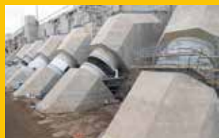
PRODUCTION DE BÉTON
