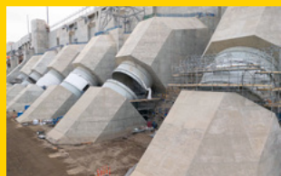
PRODUCTION DE BÉTON
