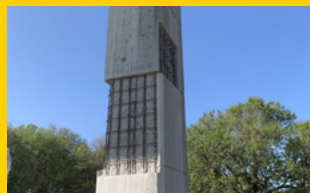
RÉPARATION DU BÉTON
