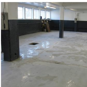
Environ 500 pi<sup>2</sup> de l'ancien plancher de béton de 7 000 pi<sup>2</sup> a dû être retiré au départ et la dalle de béton refaite. La rapidité étant de mise, les installateurs ont choisi le SikaQuick® 1000, un mortier à durcissement rapide conçu pour les réparations structurales telles que les routes et les parcs de stationnement de béton. Avec ce produit, la dalle serait prête à recevoir le revêtement d'époxyde après un délai d'aussi peu que 6 heures.
