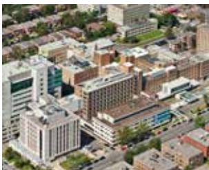
Hôpital Général Juif, Montréal, (Canada) : Installation d'un système de toiture en pleine adhérence composé de membrane Sika® Sarnafil® G410-18 (72 mils).
