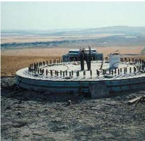
Un des plus grands défis soulevés par l'installation de cette éolienne était en fait... le vent! Il fallait que la mise en place du coulis soit terminée avant 10 h, au moment où les grands vents se lèvent. On a commencé à verser le coulis structurel Sikadur VPC à 7 h et, à 8 h 30, l'étape était terminée. Il fallait que la base de l'éolienne soit suffisamment solide pour fournir la stabilité structurelle requise, et ce, avant l'érection de la tour prévue à 10 h.
