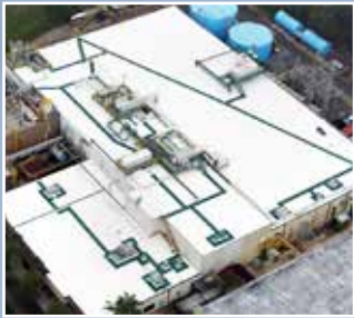
Toiture EnergySmart Roof : Réputée pour sa performance et sa longévité exceptionnelles.
