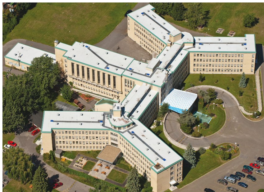
▲ Le Foyer Rousselot, un centre de soin à long terme situé à Montréal et affilié avec le centre de santé Lucille-Teasdale a opté pour une combinaison de membranes Sarnafil® EnergySmart G410-15 et G410-20.
