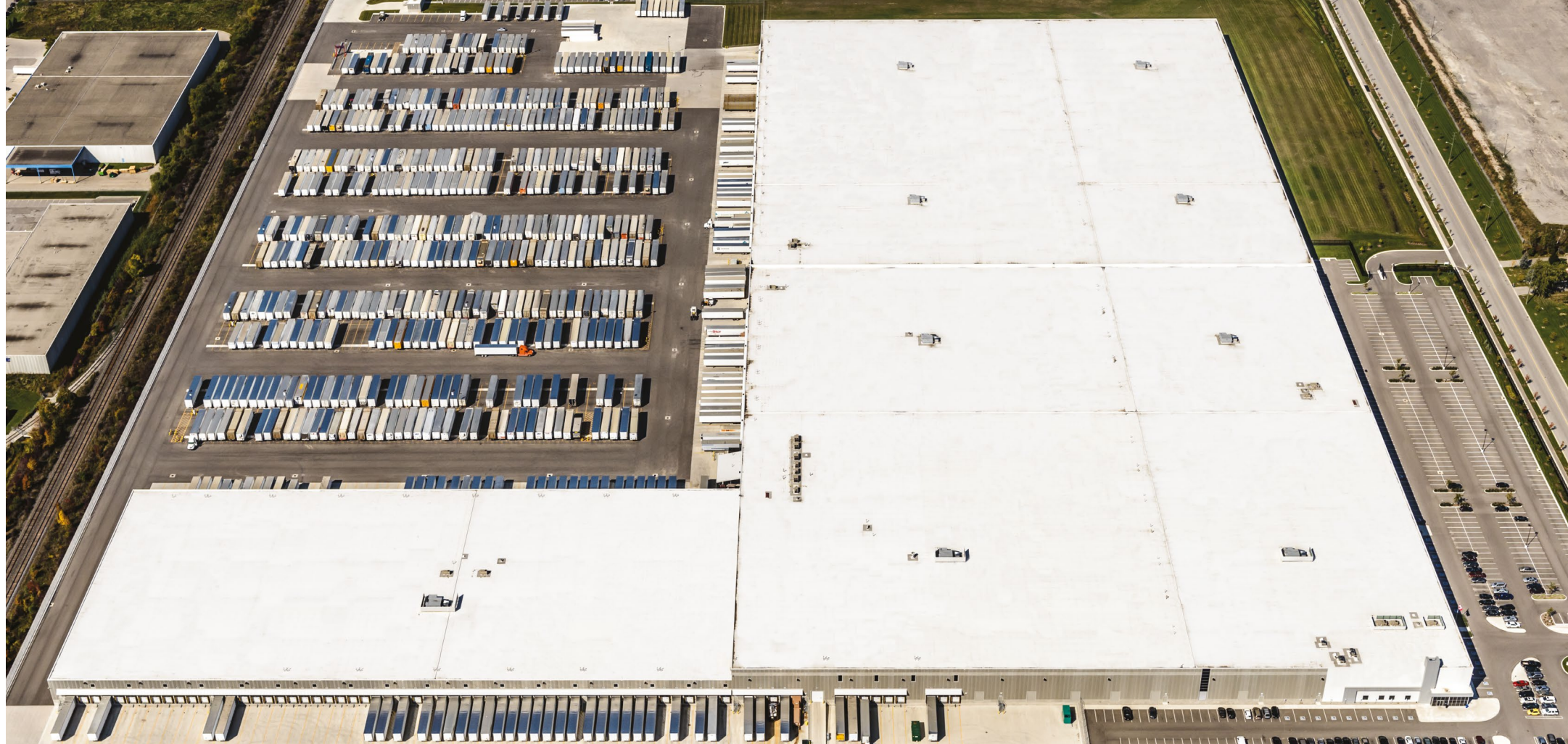
▲ Une membrane réfléchissante Sika® Sarnafil® a été utilisée pour recouvrir les 1.3 millions de pieds carrés de toiture sur un centre de distribution situé à Milton en Ontario.
