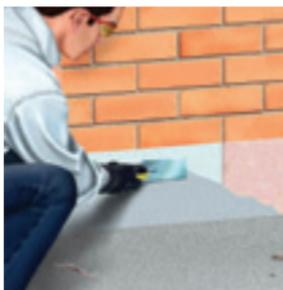
Imprégnation hydrofuge aqueuse / filtre à chlorures à base de silane et siloxane à faible teneur en COV
