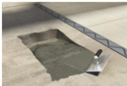
Composé à prise rapide pour le colmatage de fuites et le rapiéçage du béton
